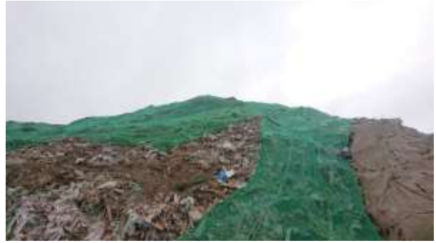
X002 營建混合物堆置場
