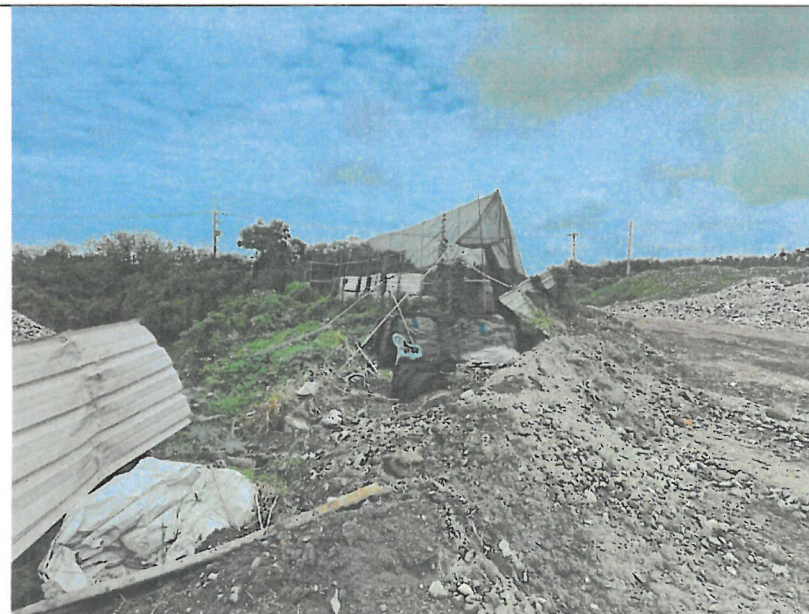
破壞圍牆設施
